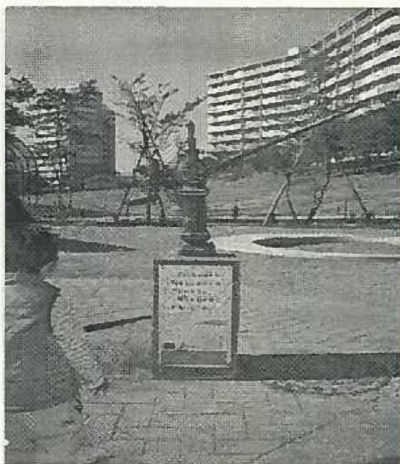
図3-14 水循環学習としての公園 (広場内の雨水を地下に貯め、手押しポンプで汲み上げる様になっています。身近な水循環学習の場として子供たちに人気です。)
