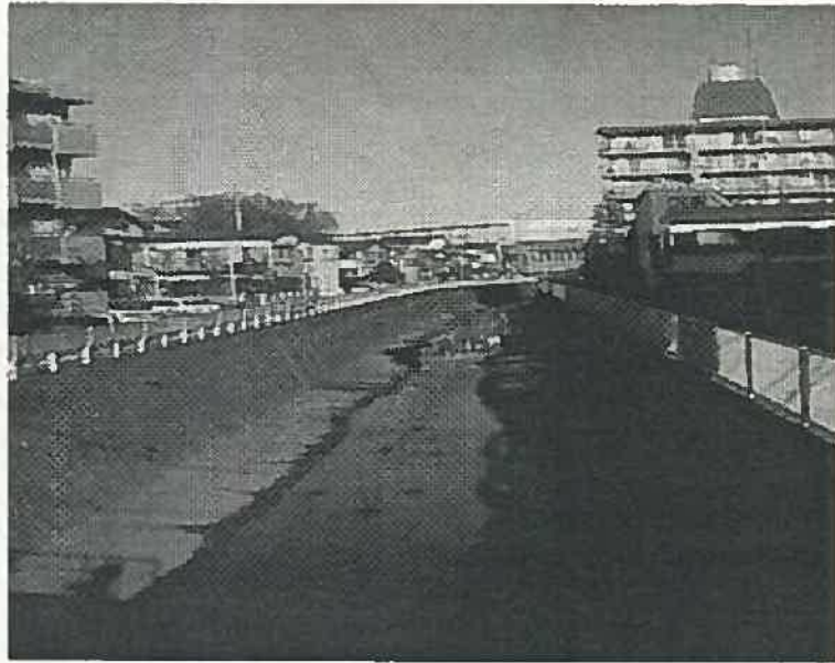
図3-4 平常時の矢上川の水量 (通常時は水量が少なく、宅地が接近していてコンクリート三面張りとなっています。)
