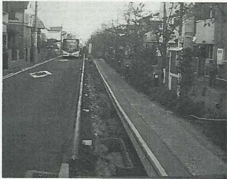
図3-6 江川せせらぎ水路 子母口付近 (等々力水処理センターの高度処理された排水を江川に流入させ親水性の公園として います。この地下には江川雨水貯留管が布設 されています)
