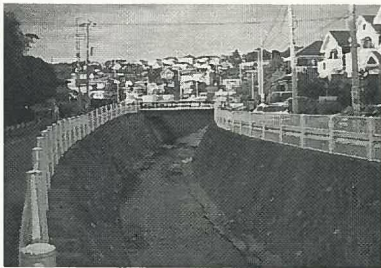
図3-5 平瀬川菅生地区 (この地区にはまだ水田や畑が残っています。しかし雨水の湧き出す量も少なくコンクリート三面張りとなっています。)
