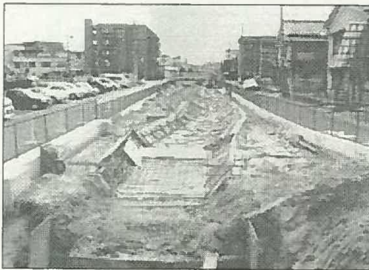
建設中の江川せせらぎ水路
