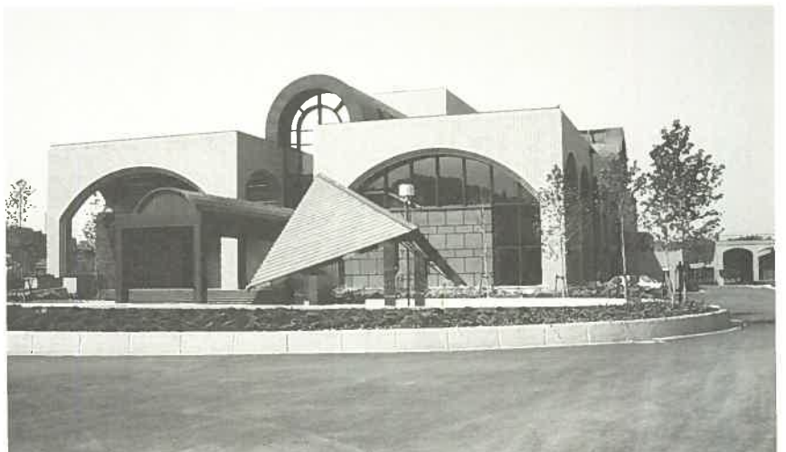
麻生水処理センター
