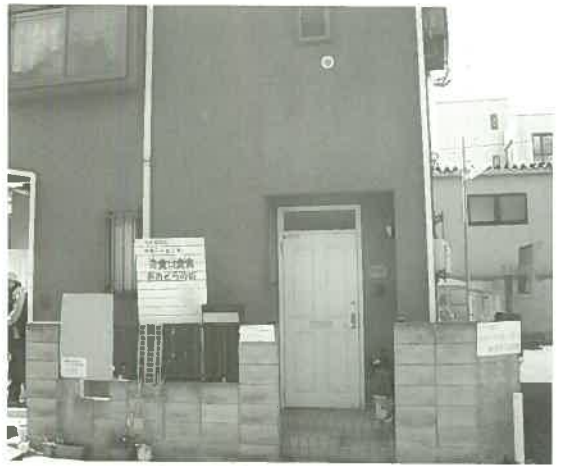
サポートセンター外観（一戸建の住宅を利用）
