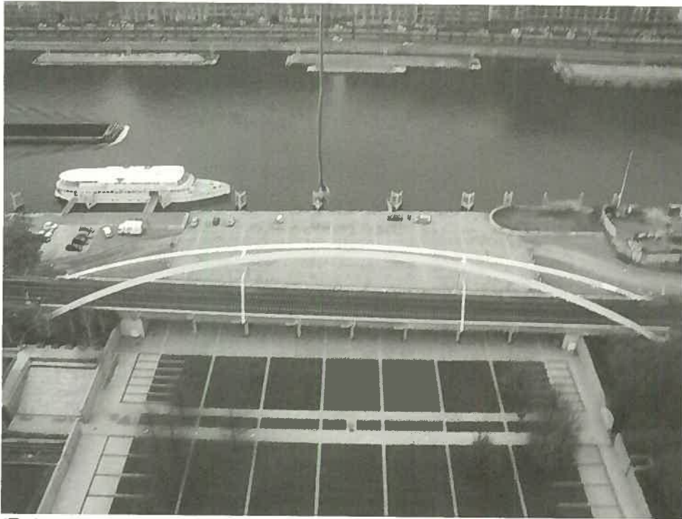
(図3) アンドレシトロエン公園 高速郊外地下鉄を高架化して公園とセーヌ川に連続性を持たせている
