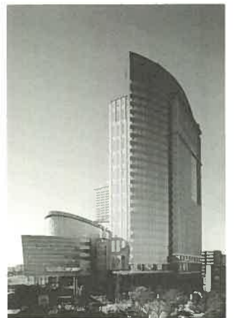
ミューザ川崎の全景
