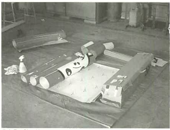
写真① 貼り付け前のシート
