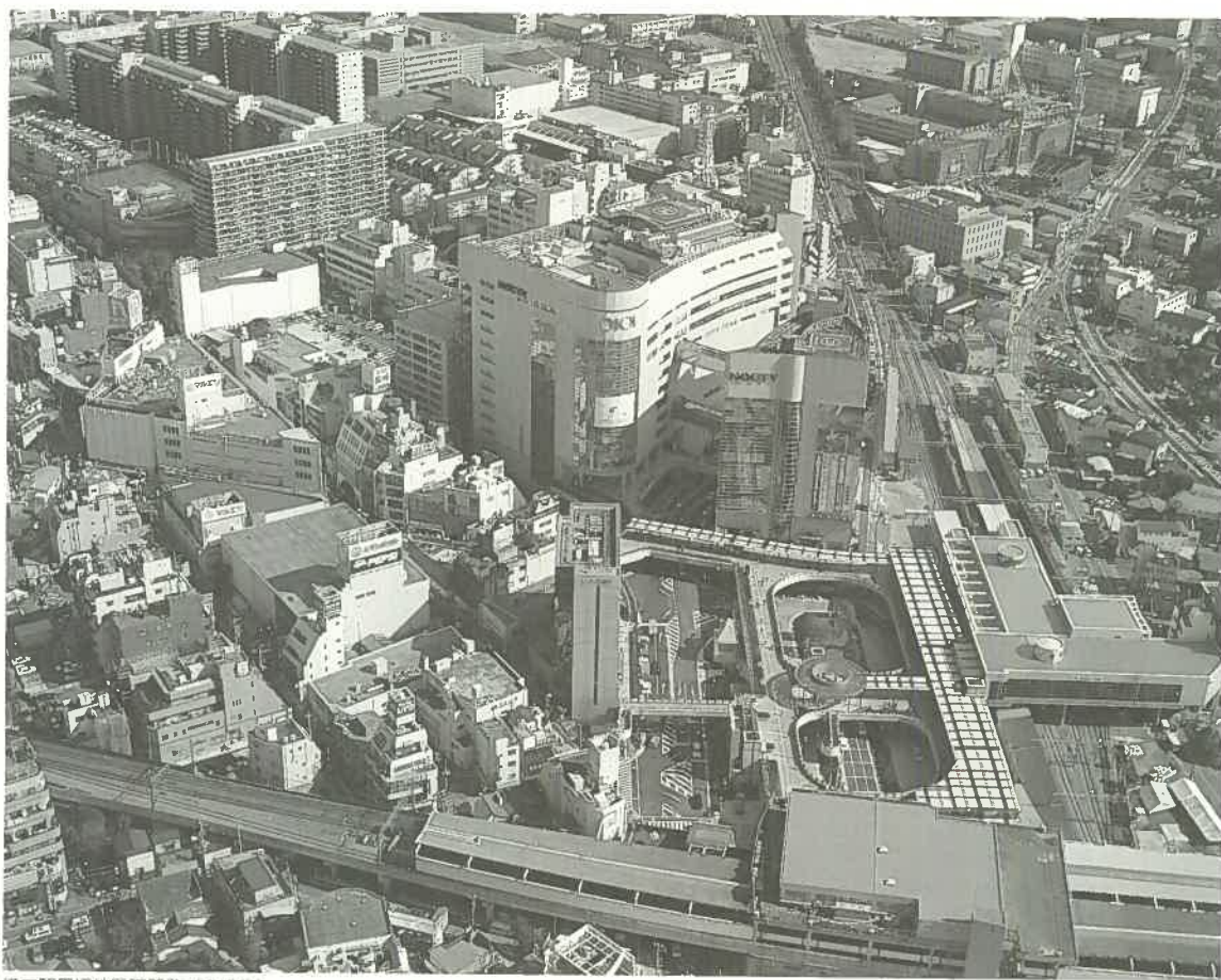
溝口駅周辺地区再開発（完成後）
