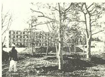
基礎工事が進む「緑の広場」
