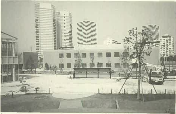
「新川崎・創造のもり」建設中の研究棟
