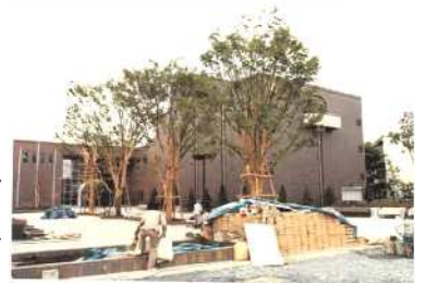
↑ 建設工事の様子
