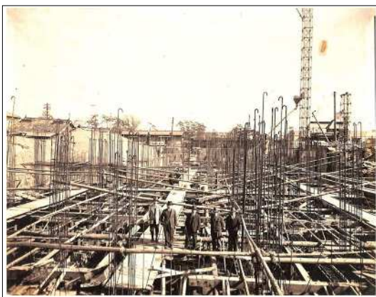
建設工事中の市本庁舎。左から2人目が直喜安二郎社長。(川崎市公文書館所蔵)
