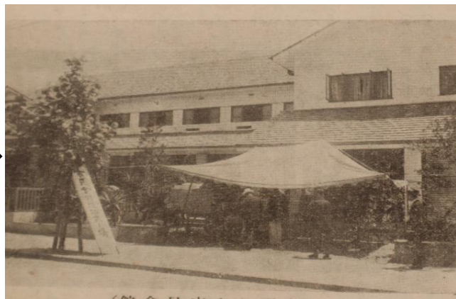
川崎市市民会館 【開館：昭和 16 年(1941) 7 月】
