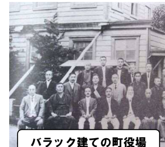
バラック建ての町役場
