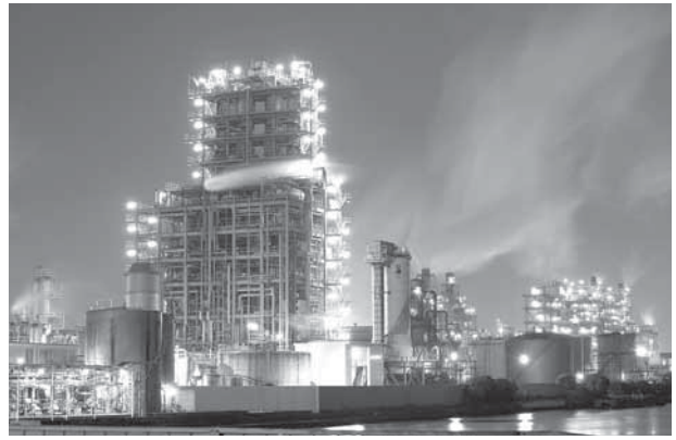
川崎の工場夜景
