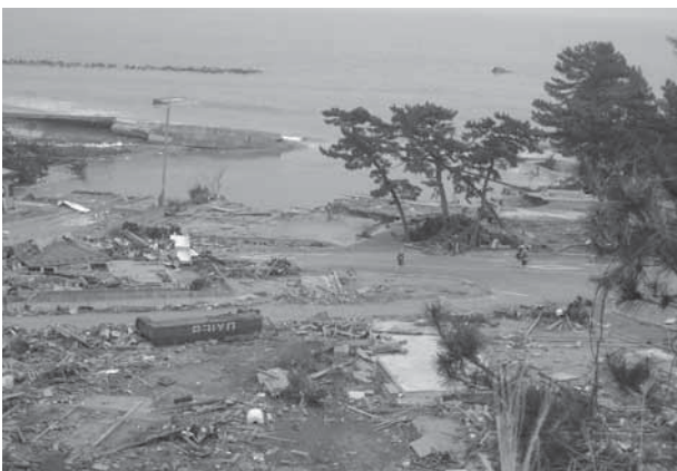
海岸沿いの被災状況
