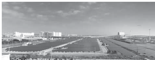
浮島太陽光発電所
