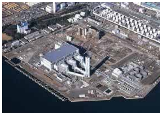
蒸気供給共同事業エリアの一部（川崎区千鳥町）
