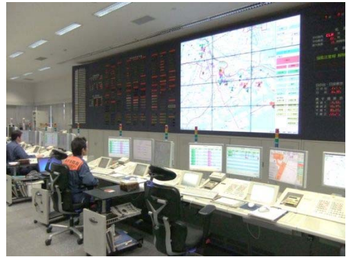
消防指令センター
