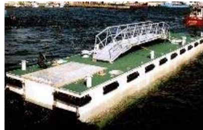
輸送用浮き棧橋
