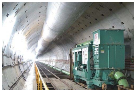
大師河原貯留管の整備
