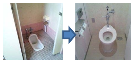
学校のトイレ改修
