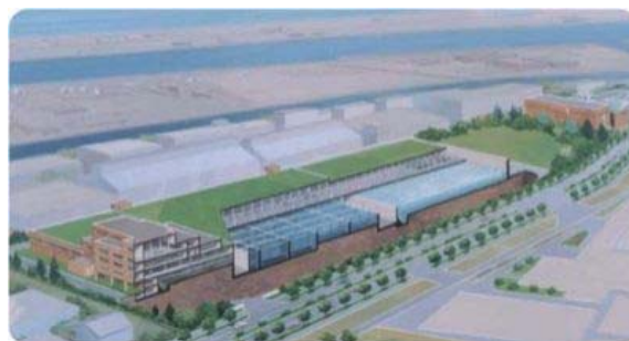
入江崎水処理センター西系再構築
