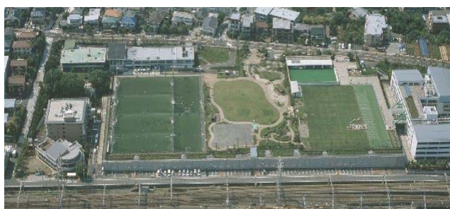
鷺沼配水池 耐震補強
