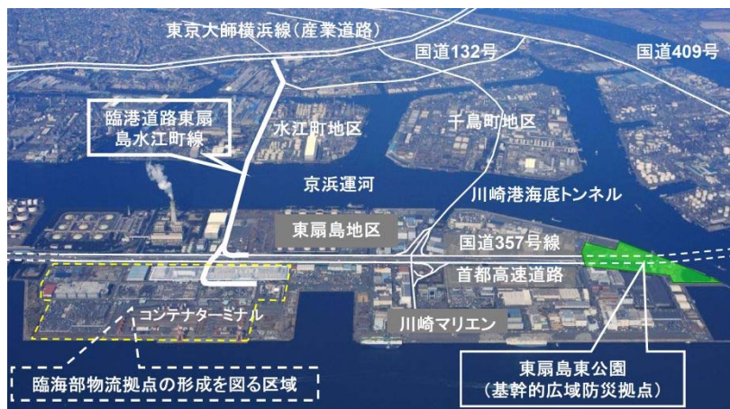
川崎港航空写真
