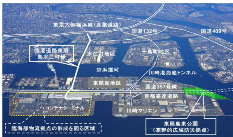
川崎港航空写真
