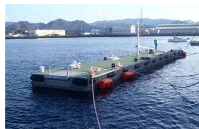
輸送用浮き栈橋
