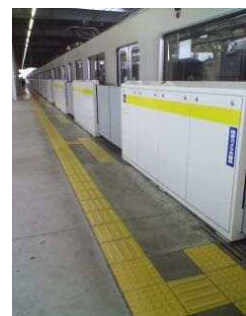
ホームドア設置
