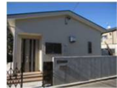
整備後の会館
