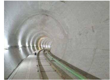
大師河原貯留管の整備
