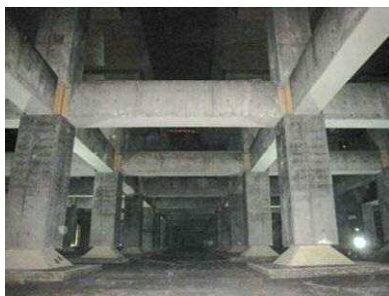
鷺沼配水池 耐震補強
