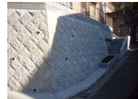
宅地防災工事
