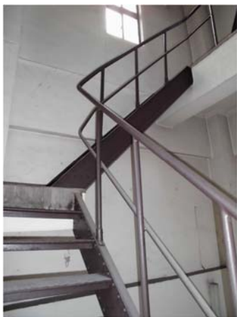
時計塔内部の鉄骨階段（4階より上部）
