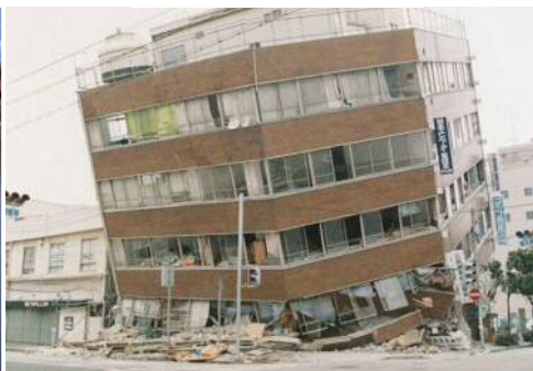
【地震による建物の倒壊】
