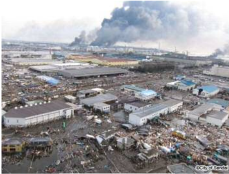
【津波による被害】
