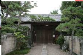
安藤家長屋門(中原区)
