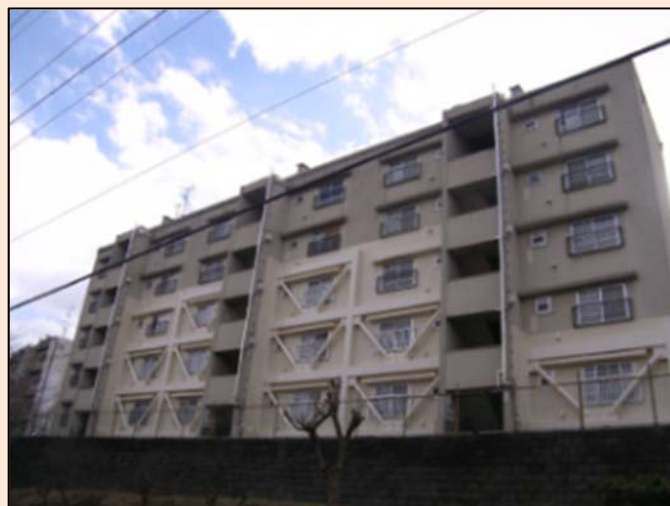
＜市営有馬第1住宅耐震改修工事＞
