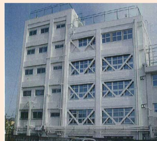
病院等特定建築物耐震改修
