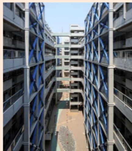
民間分譲マンション耐震改修
