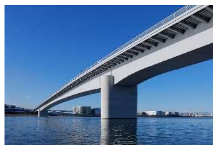
多摩川スカイブリッジ
