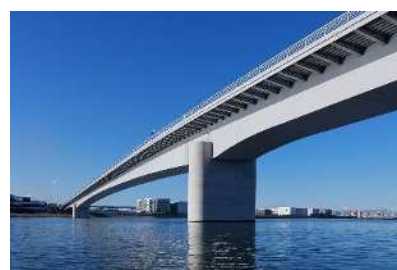
多摩川スカイブリッジ
