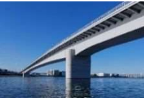
多摩川スカイブリッジ
