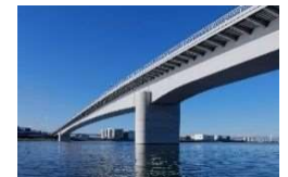
多摩川スカイブリッジ
