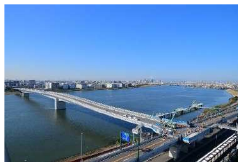
多摩川スカイブリッジ
