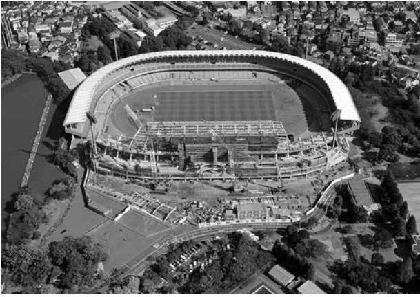
使いながらの工事
