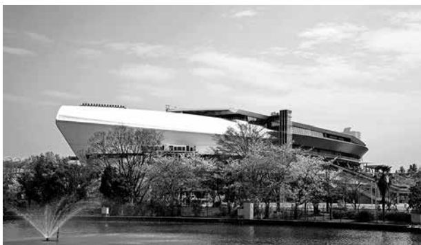
新メインスタンド(公園側から)
