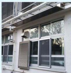
庇を設置して夏の直射日光を遮ったり、夜間換気（ナイトパージ）用の開口を設置して夏の夜間に自然換気をしたりすることで校舎全体を冷やし、快適な環境に改善します。
