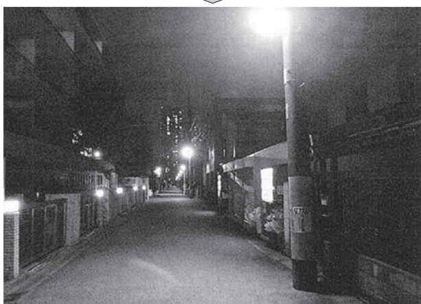
LED化工事施工後
