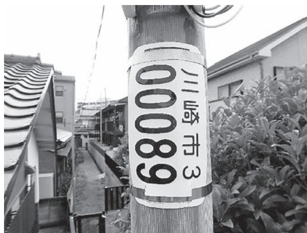
各防犯灯に設置される管理プレート
