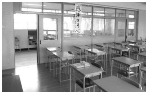
▲再生整備により改修された教室
