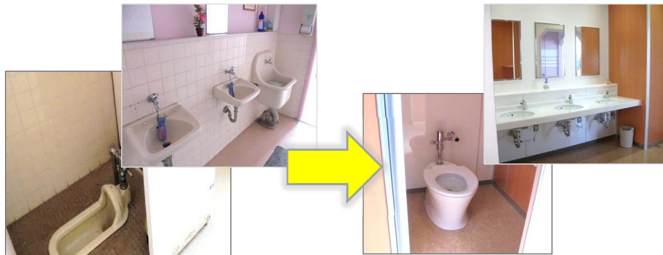
学校トイレ改修前
