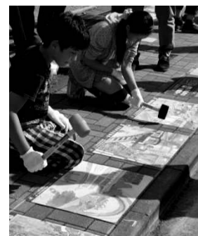
路面啓発シートの設置
