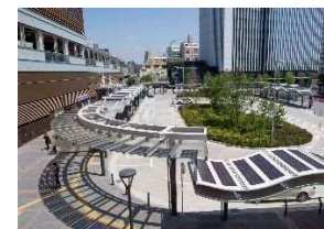
■駅前広場の整備 武蔵小杉駅南口地区東街区
