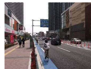
■歩道・自転車専用通行帯の整備 東京丸子横浜線
