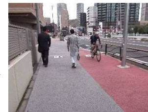
■現道拡幅 国道409号(市ノ坪)
