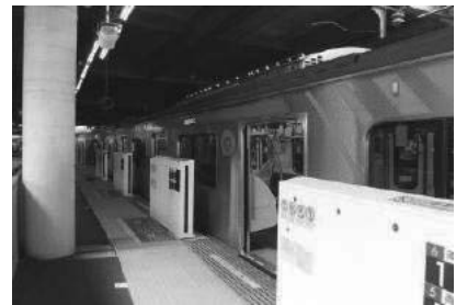
東急大井町線溝の口駅ホームドア
