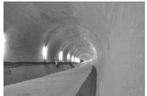
大師河原貯留管
