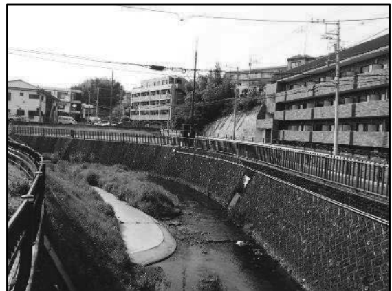
河川改修後の状況（平瀬川支川）
