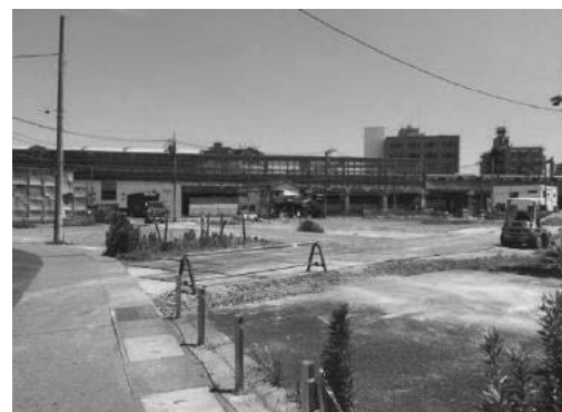
区画整理事業が進む登戸駅前 平成29（2017）年7月
