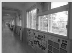
改修により明るくきれいになった廊下
