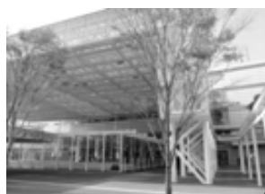
川崎駅東口駅前広場
