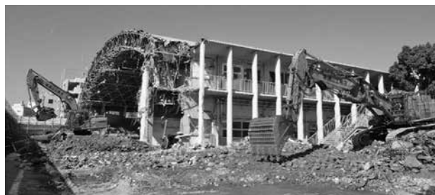
市体育館解体工事の様子
