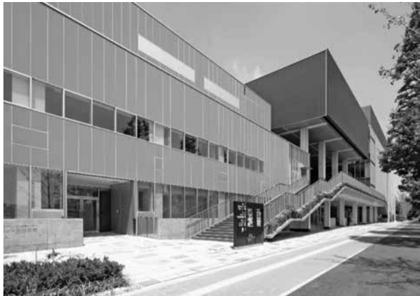
竣工後の施設外観
