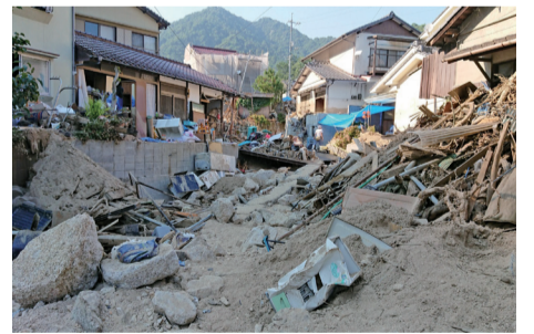
広島県坂町の被災現場(7月18日撮影)
