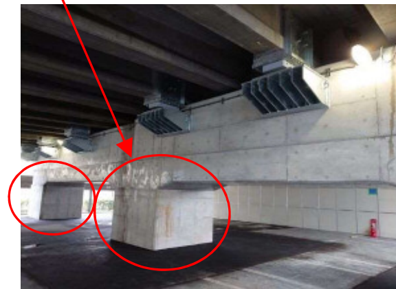
塩浜陸橋(川崎市)【コンクリート巻立て補強】
