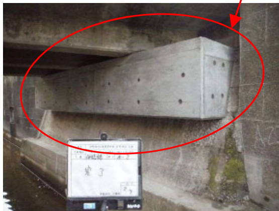
伊勢橋(中原区)【桁かかり長の確保】
