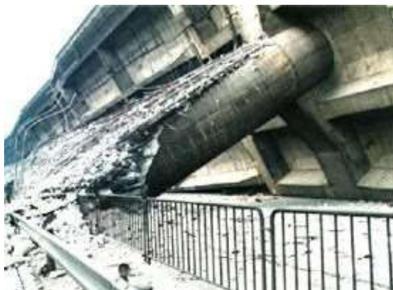
兵庫県南部地震による橋脚の倒壊
