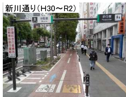
歩道の通行分離
