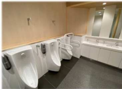
トイレ改修後(麻生区役所)
