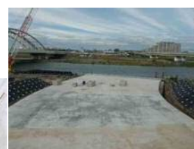
放流部堤外水路
