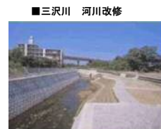
三沢川 整備箇所 黒川地内
