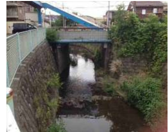
柿生橋架替前
