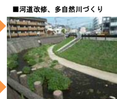
平瀬川支川 宮前区菅生地内
