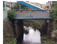
麻生川 柿生橋
