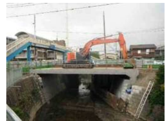
橋梁架替（半断面）
