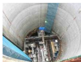
分流部立坑内躯体
