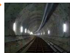
五反田川放水路トンネル内部
