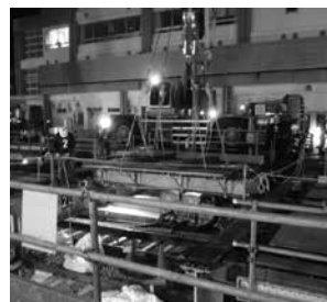
大型クレーンによる 軌道の撤去状況
