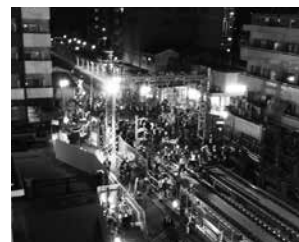
工事開始の状況 (東門前駅付近)
