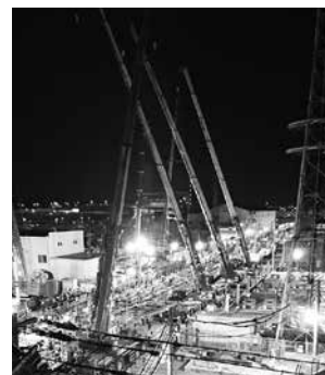
大型クレーンによる 軌道の撤去状況
