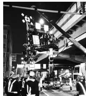
踏切撤去の状況 (産業道路付近)
