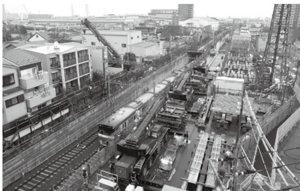
地下から地上に向かって走行する試運転列車
