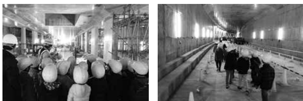
工事中の地下トンネルに潜入する児童たち
