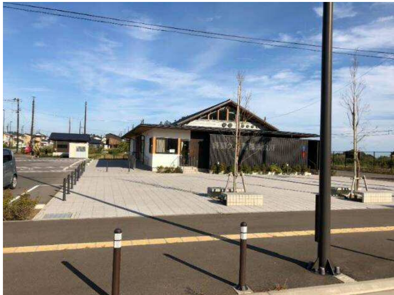
野蒜ヶ丘地区センター
