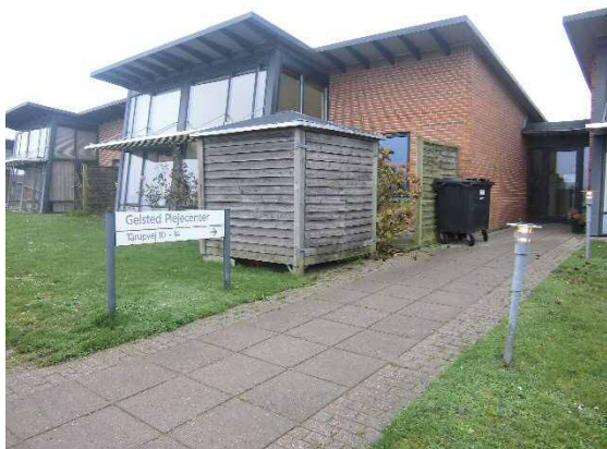
施設外観の様子
