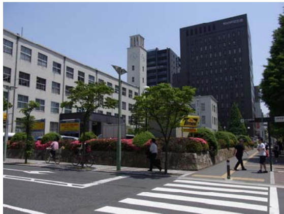
No.5：計画地南側歩道より
