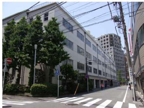
No.2 : 計画地北東側道路より
