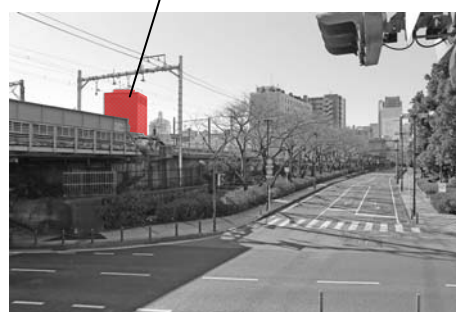
写真9.6.1-1 No.1 : 多摩川サイクリングロード
