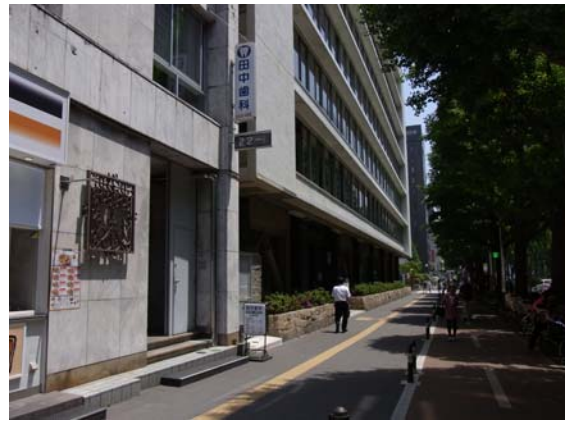
No.6：計画地南西側歩道より
