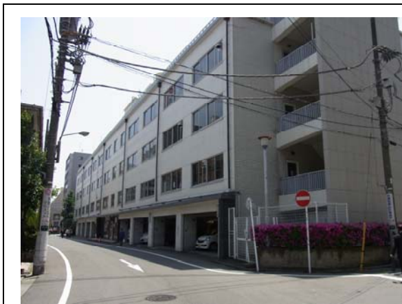
No.1 : 計画地北西側道路より
