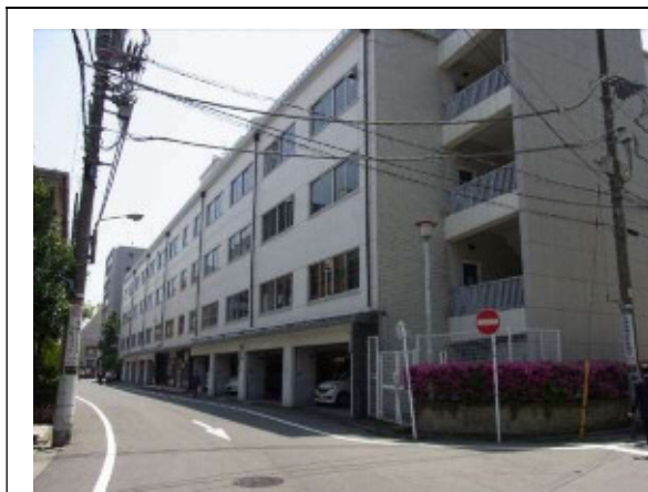
No.1 : 計画地北西側道路より
