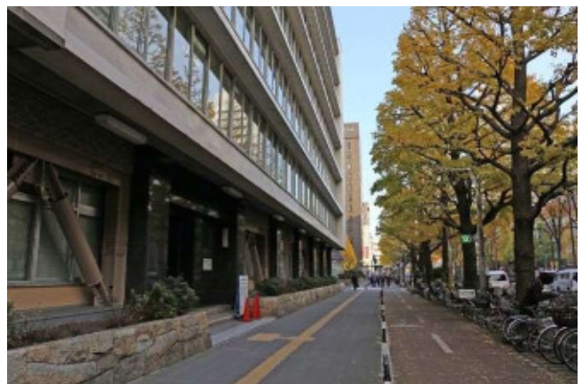
No.12 : 第2庁舎前歩道 (撮影日 : 平成 27 年 12 月 9 日)
