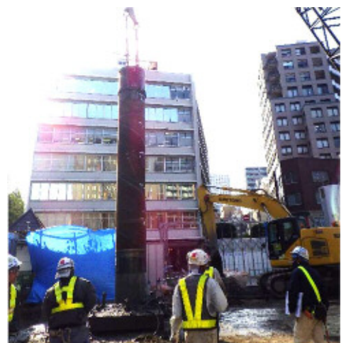
杭を穴に挿入している様子
