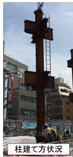
柱建て方状況
