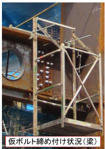
仮ボルト締め付け状況(梁)
