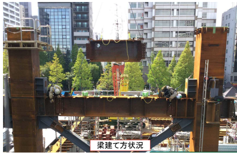
梁建て方状況
