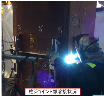
柱ジョイント部溶接状況
