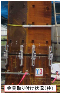
金具取り付け状況(柱)
