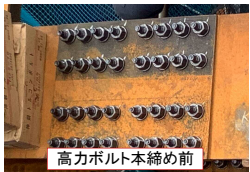
高力ボルト本締め前
