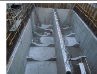
オイルタンク埋設前の地中内のコンクリートの箱
