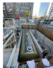
オイルタンク埋設前の地中内のコンクリートの箱
